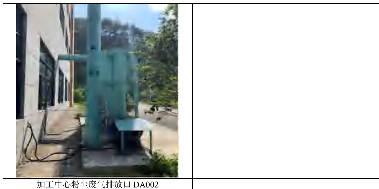
图 3-7 机科院钣金件生产项目废气治理设施现状
